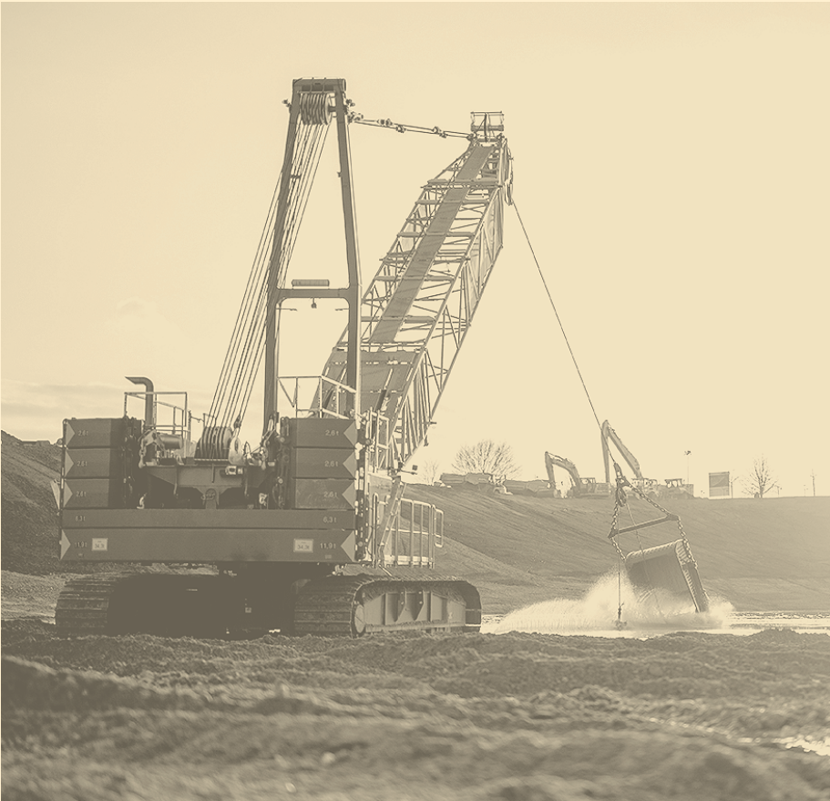
Nassbaggerung von Sanden und Kiesen mittels Seilbagger HS 8130. FOTOS: WIEDEMANN
