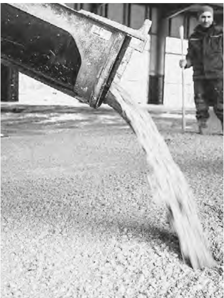
Testbaustelle bei Zosseder Großkarolinenfeld: Der R-Beton wird direkt vom Mischfahrzeug aus verteilt. FOTO: ZOSEDER
