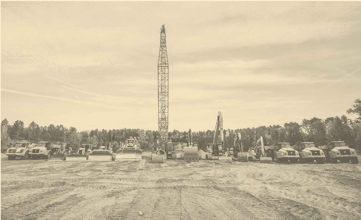
Auf der Großbaustelle in Rondorf wird mittels Seilbagger Liebherr HS 8130 an der Teilverlegung des Galgenbergsees unterstützt.
